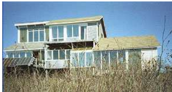
Τα μεγάλα παράθυρα και ο νότιος προσανατολισμός του κτηρίου εκμεταλλεύονται καλύτερα την ηλιακή ενέργεια
